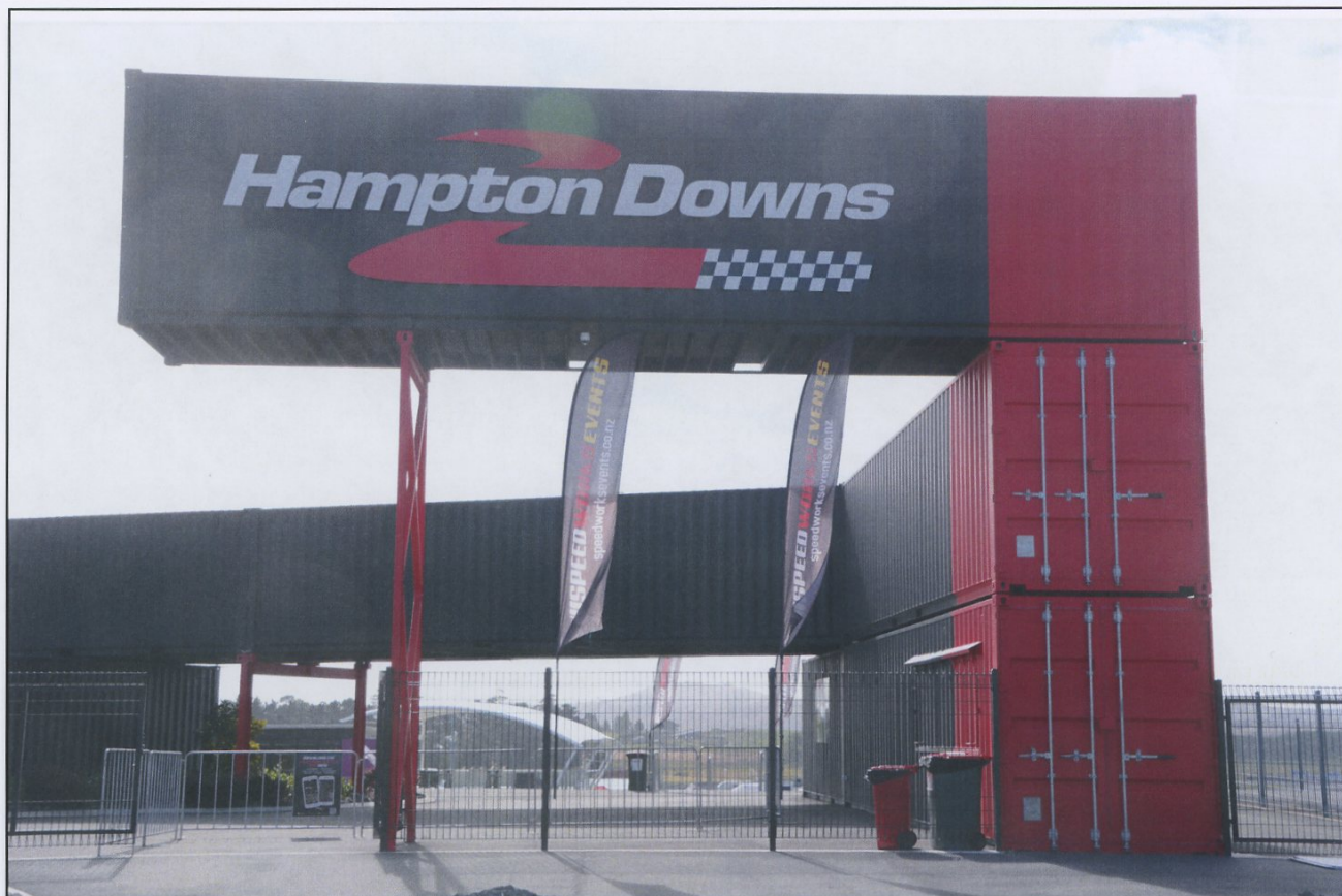
Bild 234 DSC 5717 Hampton Downs publikentré av gamla containrar.
